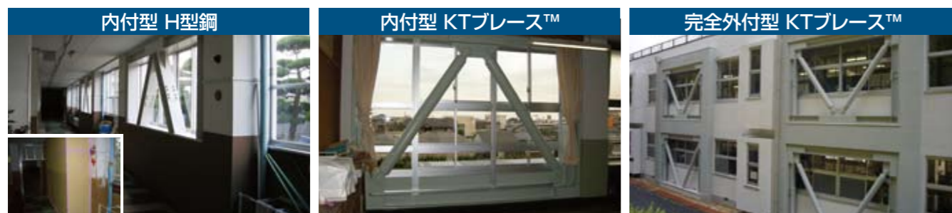
▲ 施工風景 (内部は使用しながら施工)
